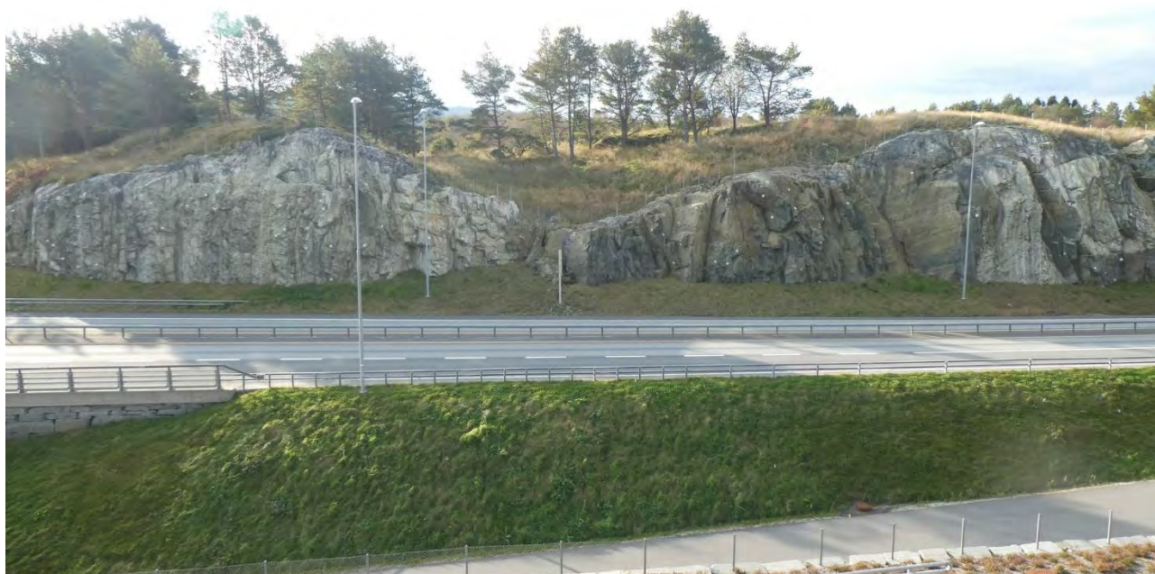
Figur 10: Bergskjæring ved Hagelsundbrua.
