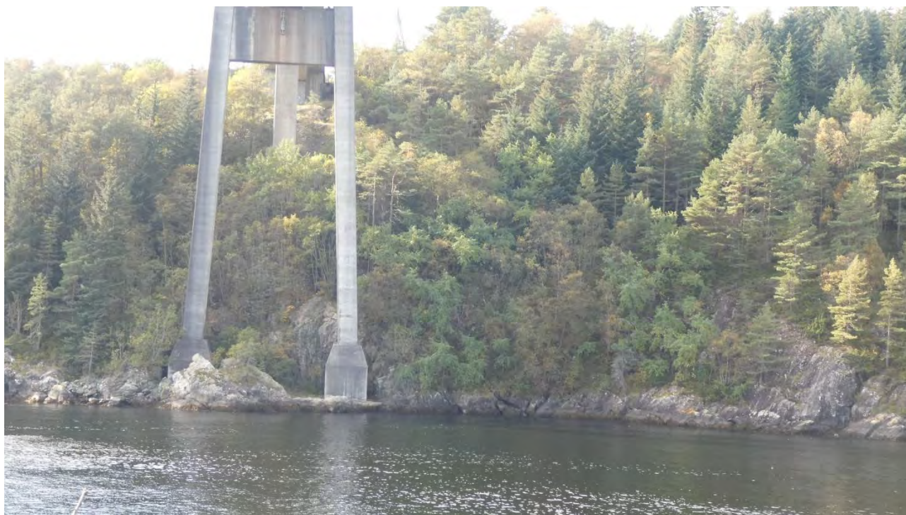
Figur 11: Foto av området ved eksisterende fundament for Hagelsundbrua på Flatøy-siden.
