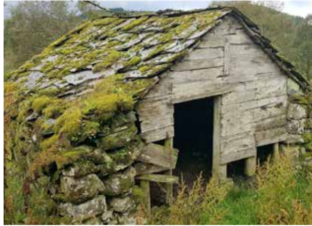
Utløer på Helland (gbnr. 38/8 verneklasse B). Denne utløer er den einaste me har registrert i kommunen som har naturheller på taket.
