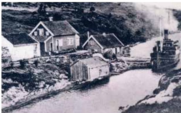
Bilete av Nordangervågen, truleg tidleg på 1920-talet. Bygningen midt i bildet er meieriet med ishuset til venstre. Nede ved dampskipsbrygga ligg butikken til Nordangervaag Handelsforening og framst er eit nothus. I dag er alle desse bygningane rivne. Utlån: Johannes Birkeland.
