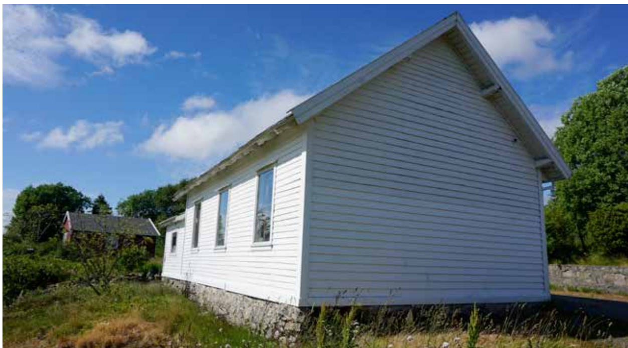
Vågenes bedehus (gbnr.29/11/1 verneklasse B) er det eldste, ståande bedehuset i Radøy kommune. Det vart bygd i 1905. I 1960 vart det bygd på i nord og i aust. Det høyrer ein utedo til bedehuset.
