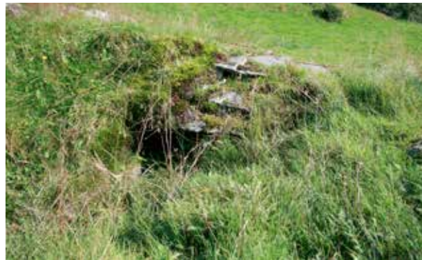
Den såkalla «Steffakjellaren» på Halland (gbnr. 60/4 verneklasse B) er ein liten jordkjellar som er murt opp mellom ein bergvegg og ein stor stein.
