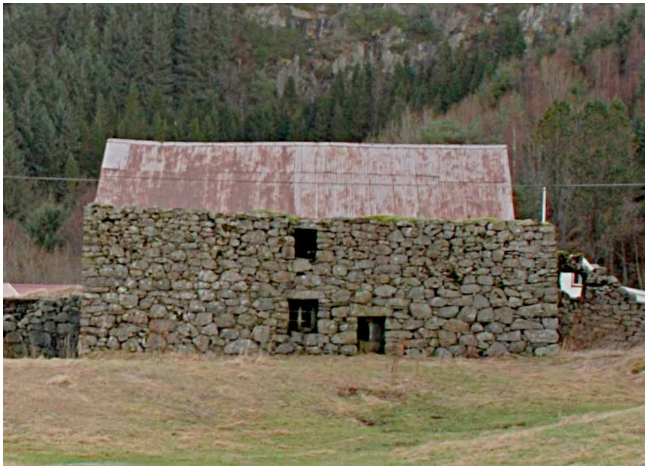
Steinløa på Nøttveit (gbrnr. 49/4 verneklasse B). Løa er ein typisk representant for løer i Nordhordland ved vernemurar, grindverk som reisverk og tømra flor.
