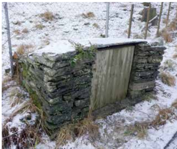
Brønn på Gjerde (gbnr. 100/12 verneklasse C) med murte sidekantar og innvendig trapp ned til vatnet.
