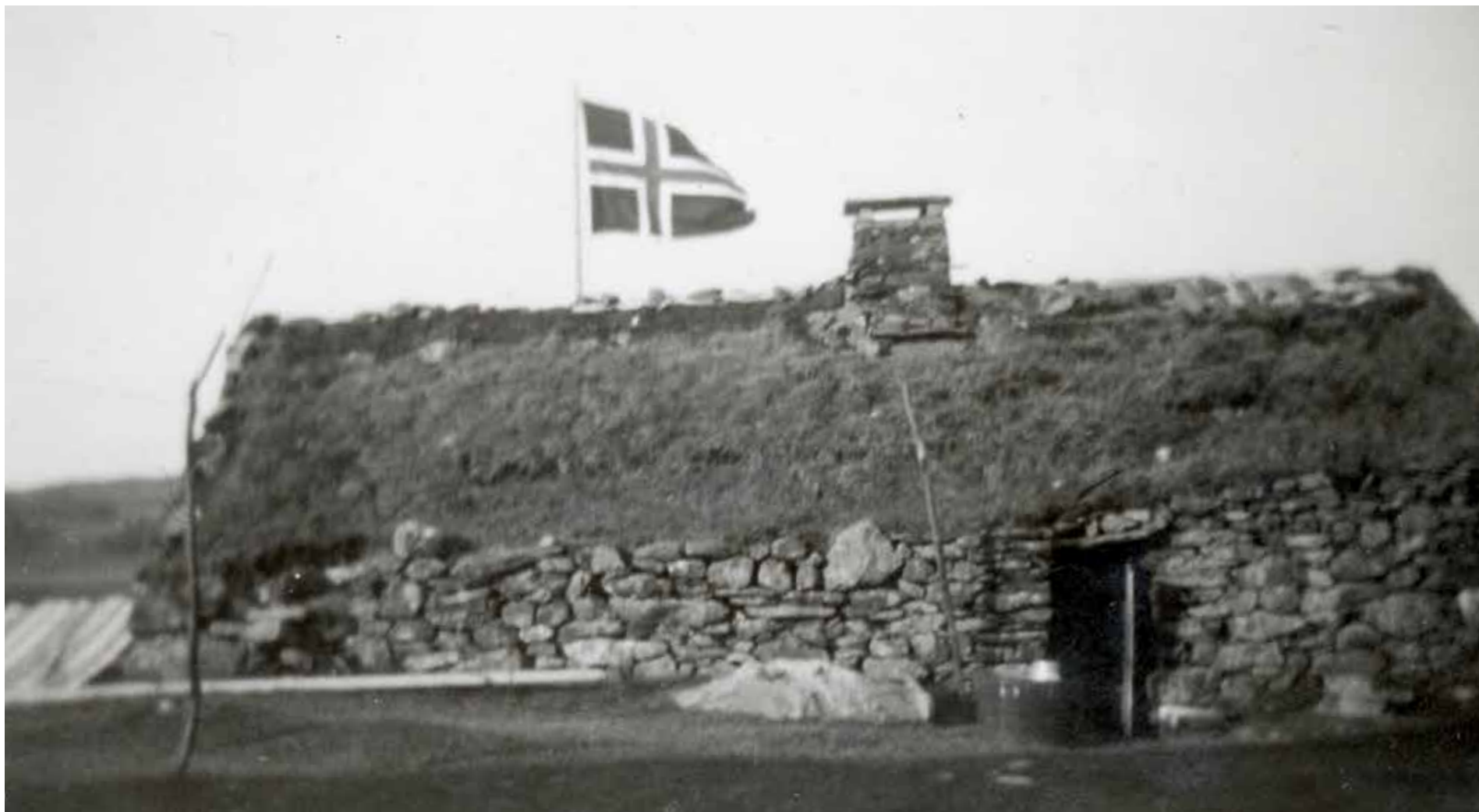
Steinkonstruksjonar er vanleg i vernemurar på gamle hus, men også større delar av våningshuset kunne vera murt, slik som på det gamle våningshuset på bruket Pusse på Nordanger (gbnr. 15/3). Huset er seinare rive.
