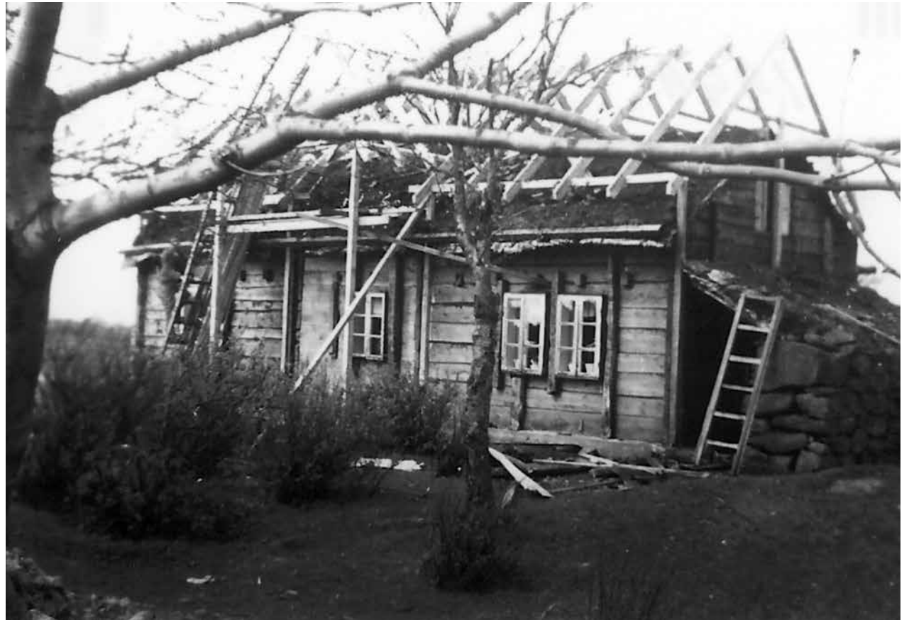
Det var lågt under taket på lemnen i dei gamle lemstovene. Dei aller fleste lemstovene som står i dag har difor fått løfta taket og nye sperr med brattare takvinkel. Biletet viser ombygging av ei lemstove på Taule (gnr 71/6). Utlån: Alf Taule.
